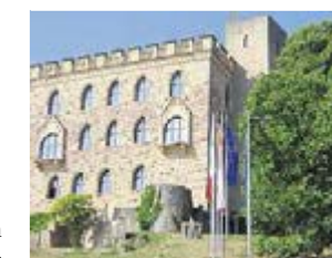
In alter Pracht: Das Hambacher Schloss wurde aufwendig renoviert.
